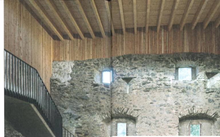
Die mittelalterliche Ruine bildet im Süden die landschaftsprägende Außenschale von Burgstüberl und Saal. Um Stützen vor der Wand zu vermeiden, wurde ein Betonrost auf die Bestandsmauer gesetzt, auf dem die Hauptträger liegen. Auf der anderen Seite trägt die Mauer die Holzaußenwand.
